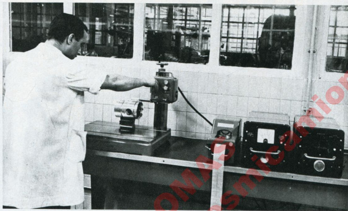
↑ El Rugosímetro Taylor Hobson en el momento de medir el grado de acabado de un émbolo motor
